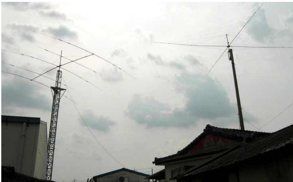
<그림20> 원격지에 사용 중인 야기안테나와 스파이더빔안테나 (7~24MHz)
